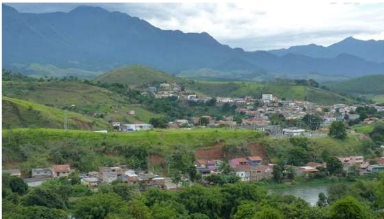
Figura 71 - Em primeiro plano área de risco de deslizamento e de inundação. Nota-se o corte realizado na encosta e a ausência de Infraestrutura para contenção da encosta.
